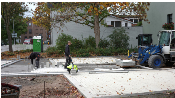
Am Umbau der Fußgängerzone wurde zuletzt fleißig gearbeitet. Hier der Stand der Arbeiten am Beginn der Hochstraße Mitte Oktober. Foto: A. Bürger
