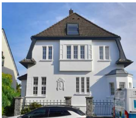
Fassade in Süchteln vor und nach der Sanierung. Fotos: privat (oben)/A. Dalhoff
